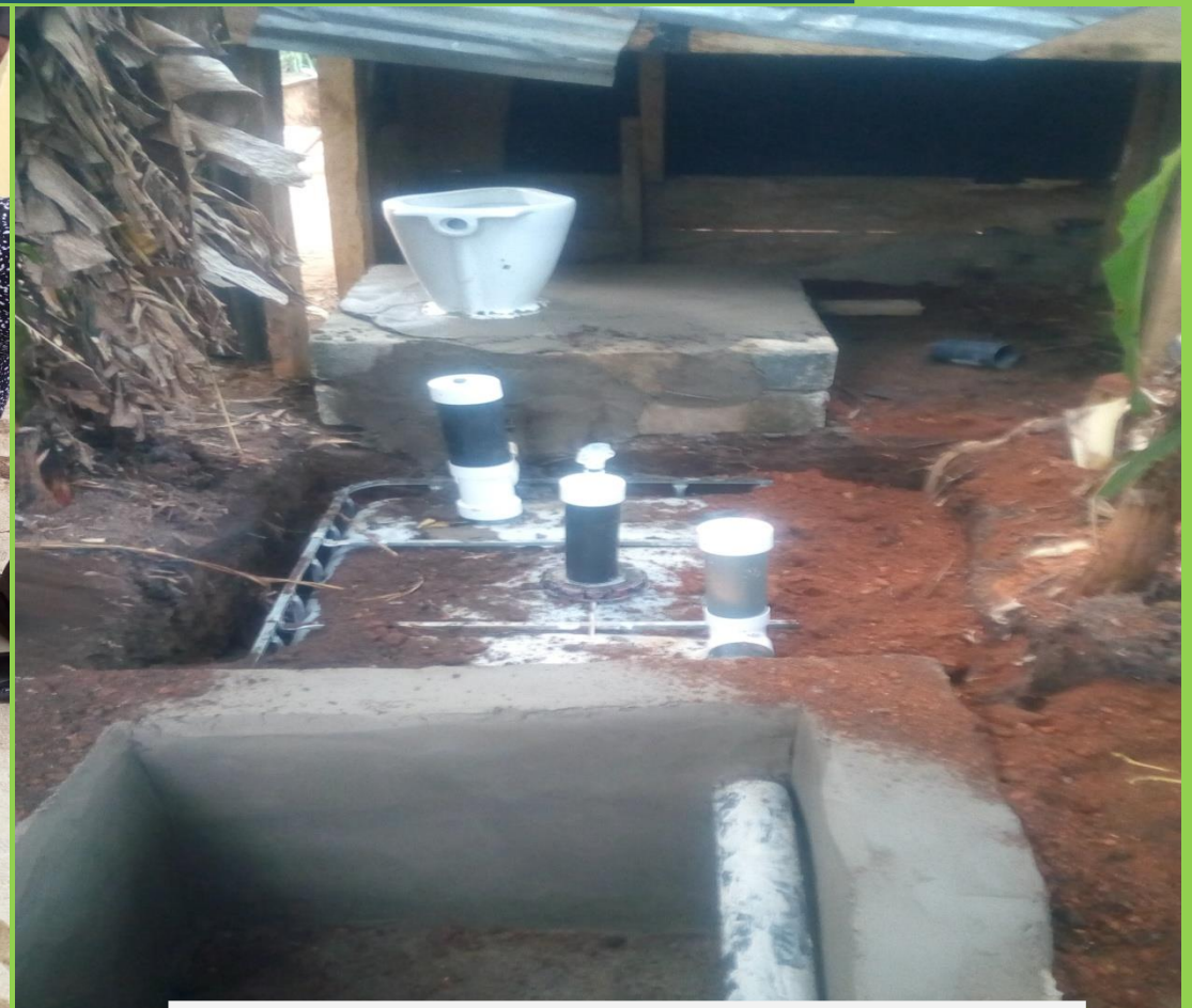
POUR FLUSH BIOGAS TOILET SYSTEM (DAS TOILET)
